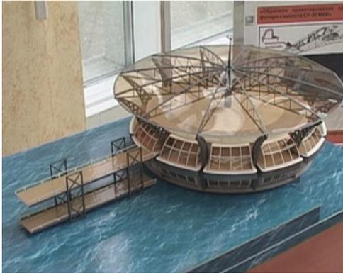
"Здание будет располагаться на воде, на специально отлитом для этого основании. На нем будут металлические лопастные конструкции. Здание будет вращаться при помощи течения воды", - рассказывает Сергей Козин, организатор проекта.
