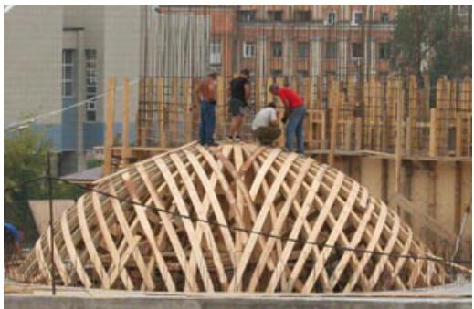
На данный момент строители монтируют полусферическую основу, на которой сформируется внутренняя поверхность так называемого «силового» купола. Он будет выполнен из железобетона и будет изготавливаться методом таркетирования – подачей бетона под давлением. Под силовым куполом будет размещен высококачественный купол-экран, на котором специальными проекторами и будет формироваться звездное небо. Планетарий сможет принять до 60 человек за один сеанс.
