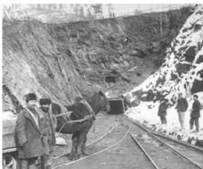
Строительство тоннеля №12. Пробивка штолен со стороны Култука
