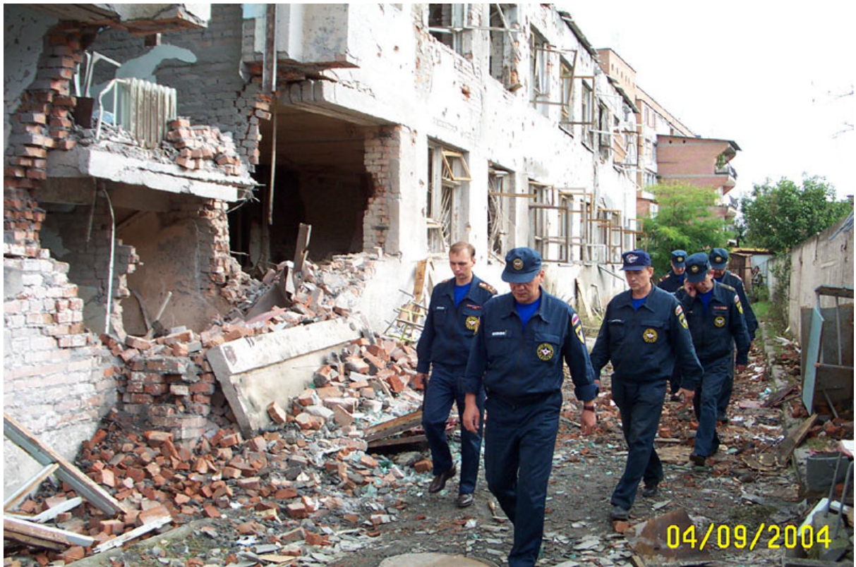
Повреждения стен после выстрелов из танка.
