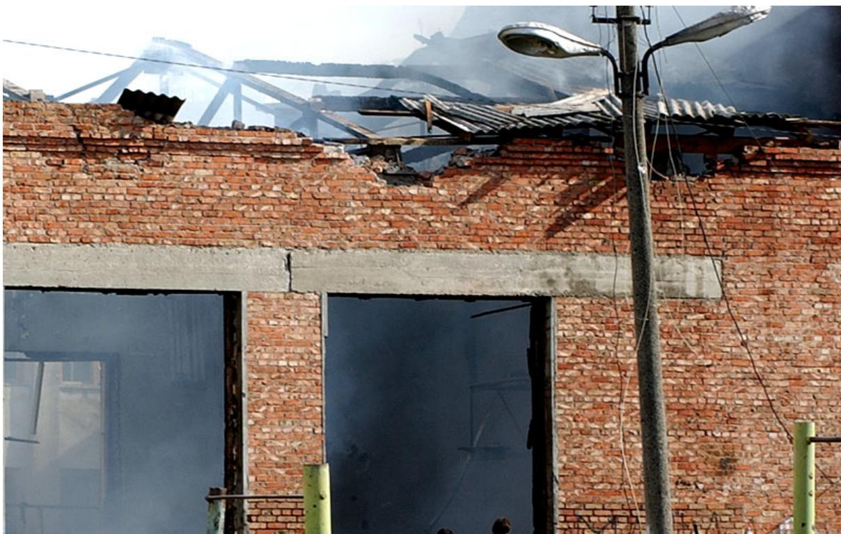
Одновременный взрыв нескольких СВУ подбросил стальные конструкции крыши. В результате был вывален большой участок кирпичной кладки на чердаке.
