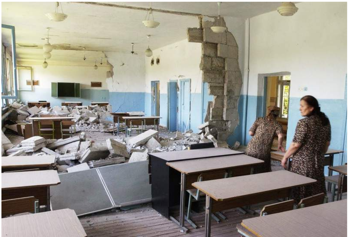
Одна граната из РПГ влетела в окно интерната на другой стороне улицы и разрушила хлипкую стену между классами.
