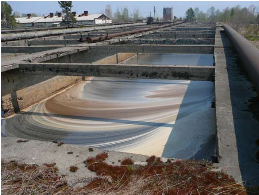
Фото 8 и 9 сделаны на очистных сооружениях комбината.
