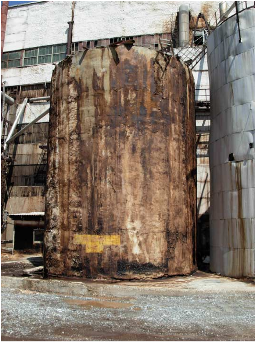
Здесь хранится опасное химическое сырье.
