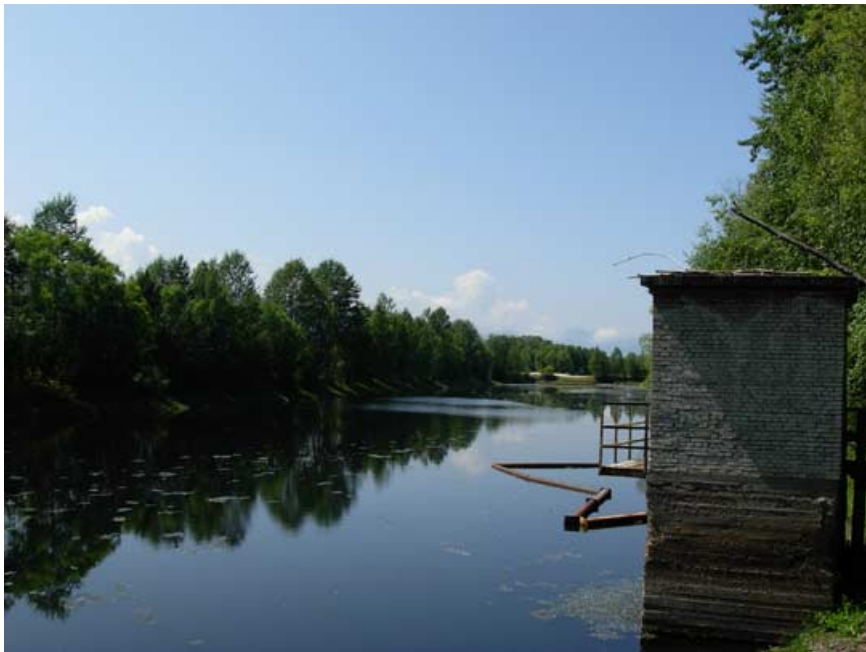
Отстойник. Через этот сарай отходы сливаются в Байкал.
