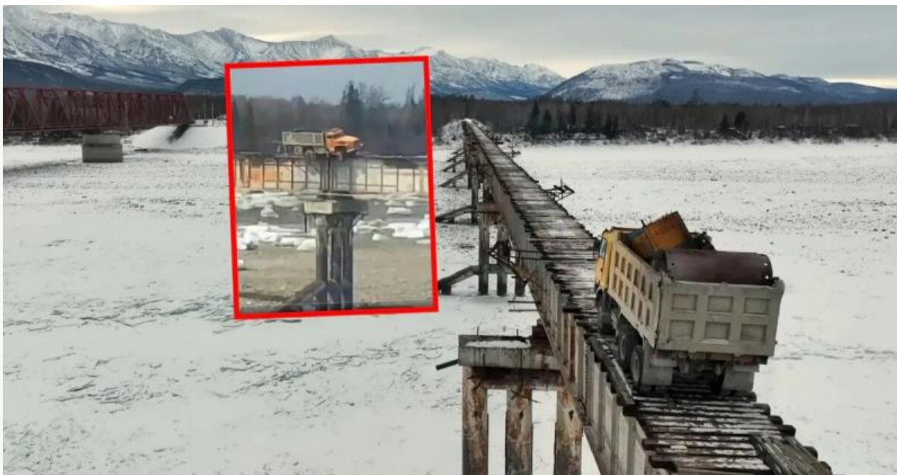
В мае 2025-го на Витимском мосту застрял грузовик: машина повисла над рекой, но её успели вытащить
