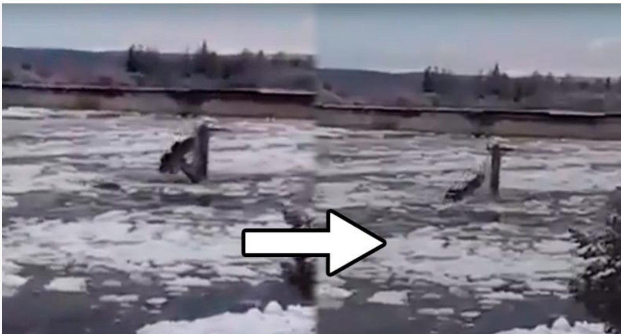
Разрушение опоры
