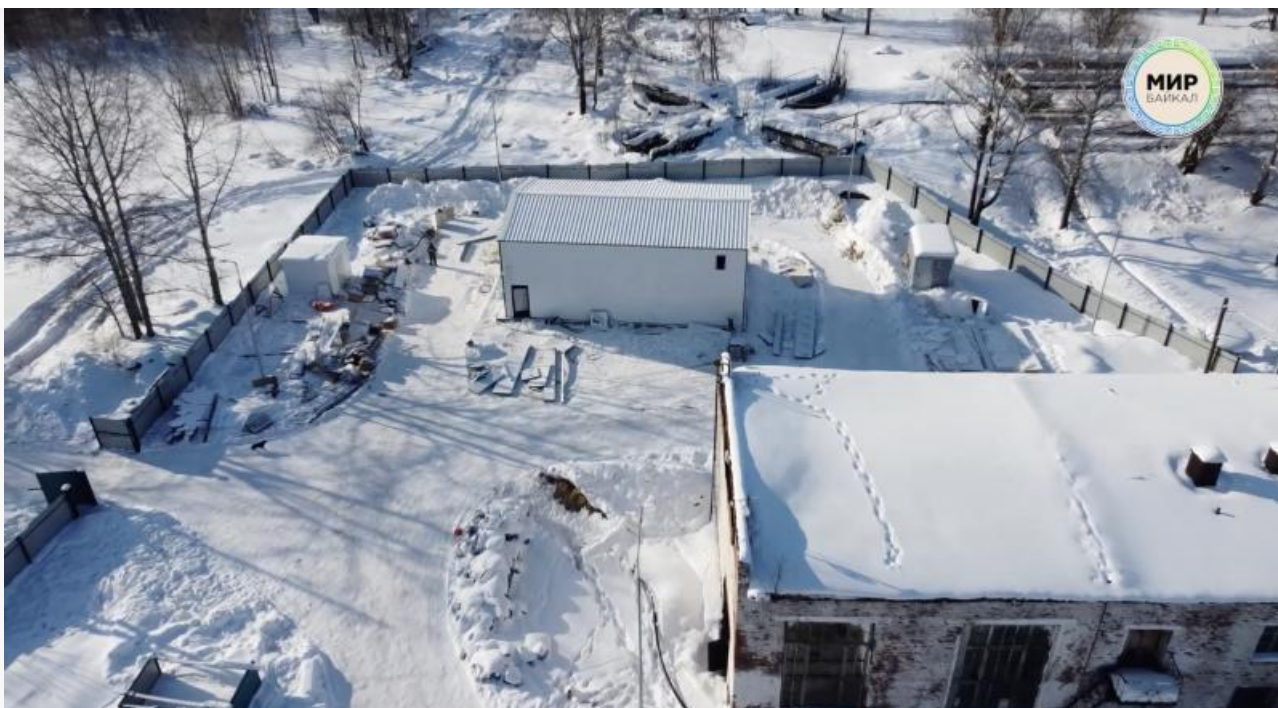
Очистные сооружения в посёлке Выдрино
