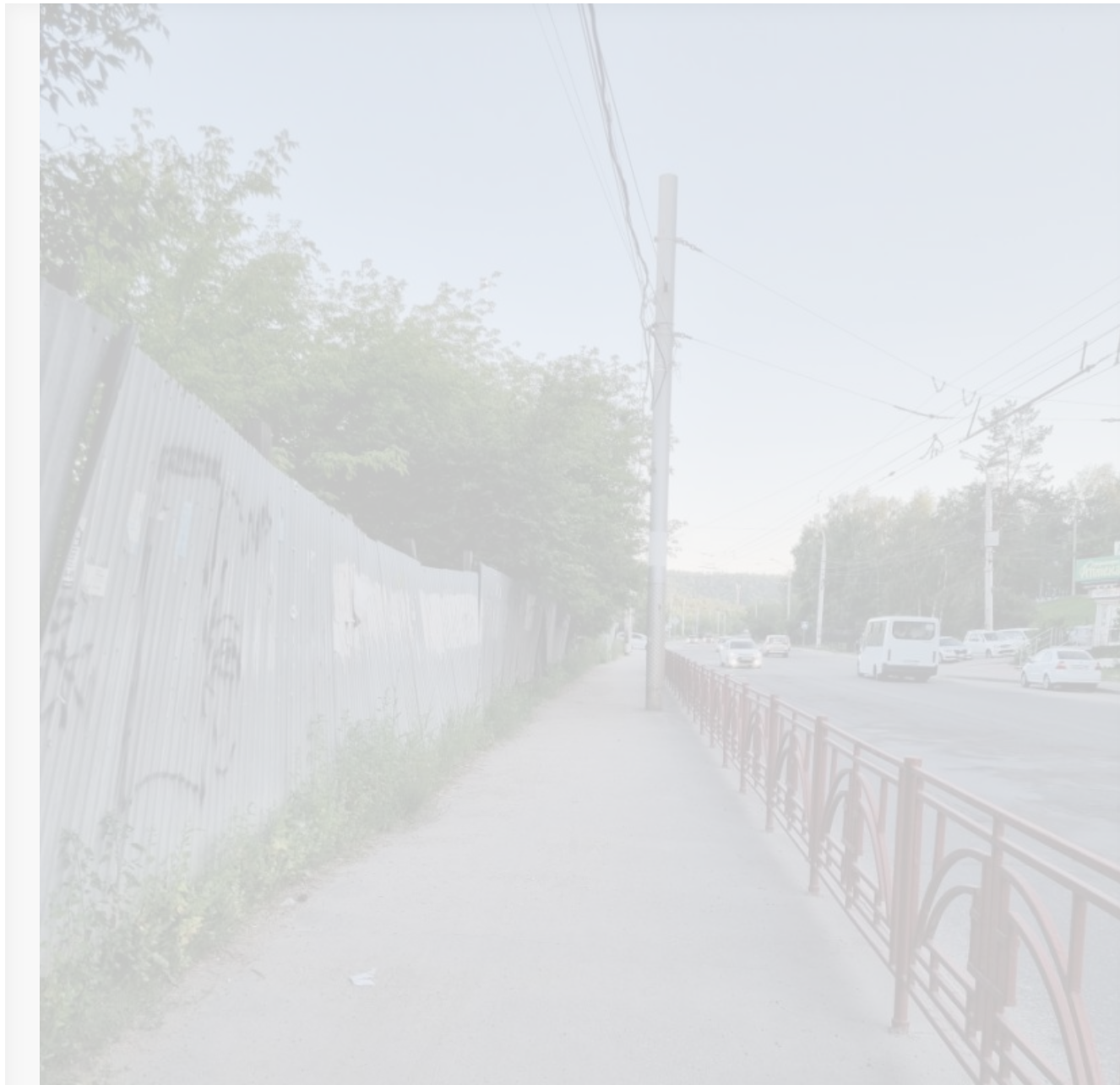
Ограждение крыш гаражных боксов от дороги
