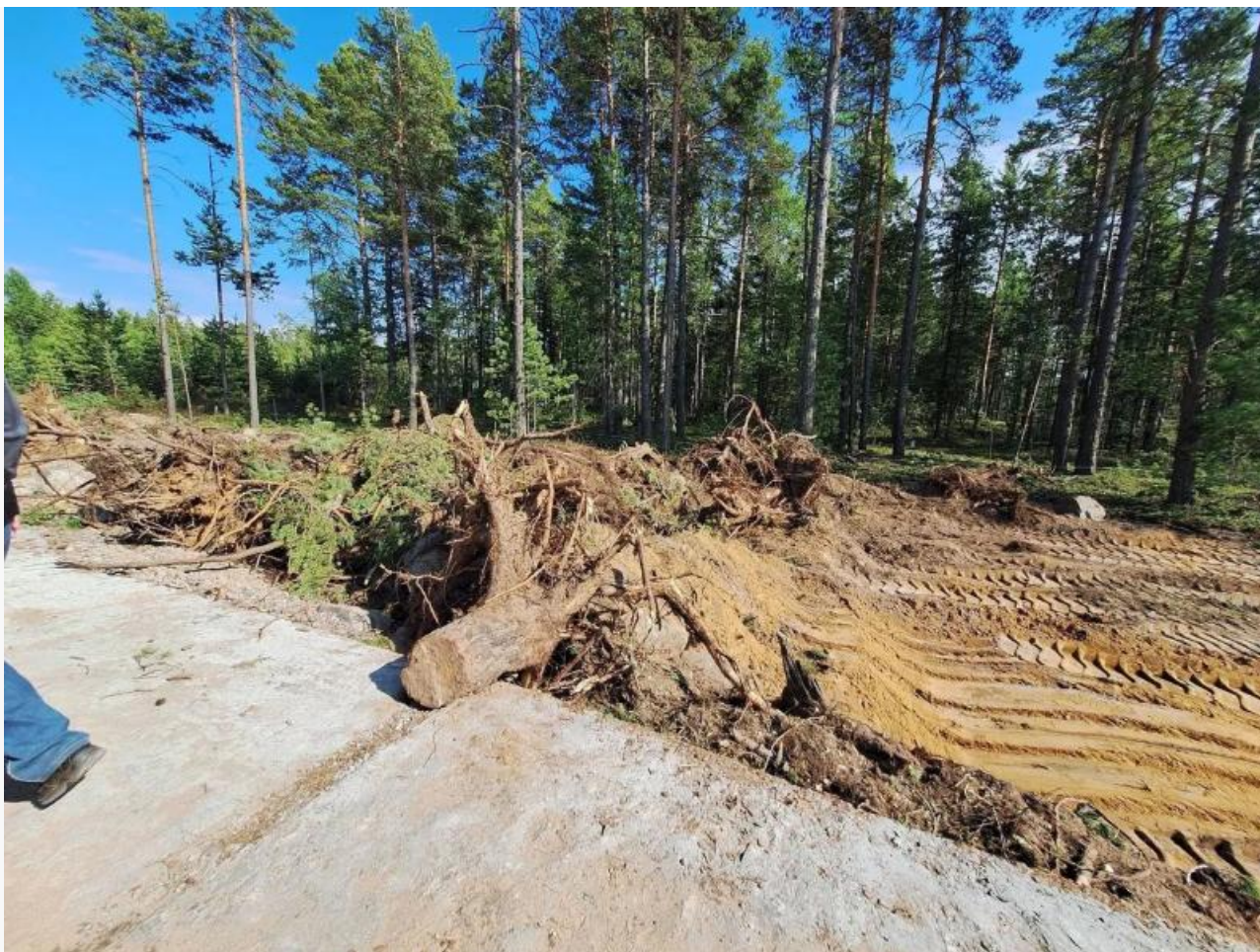
Берег Бухты Безымянной после работы тяжёлой техники
