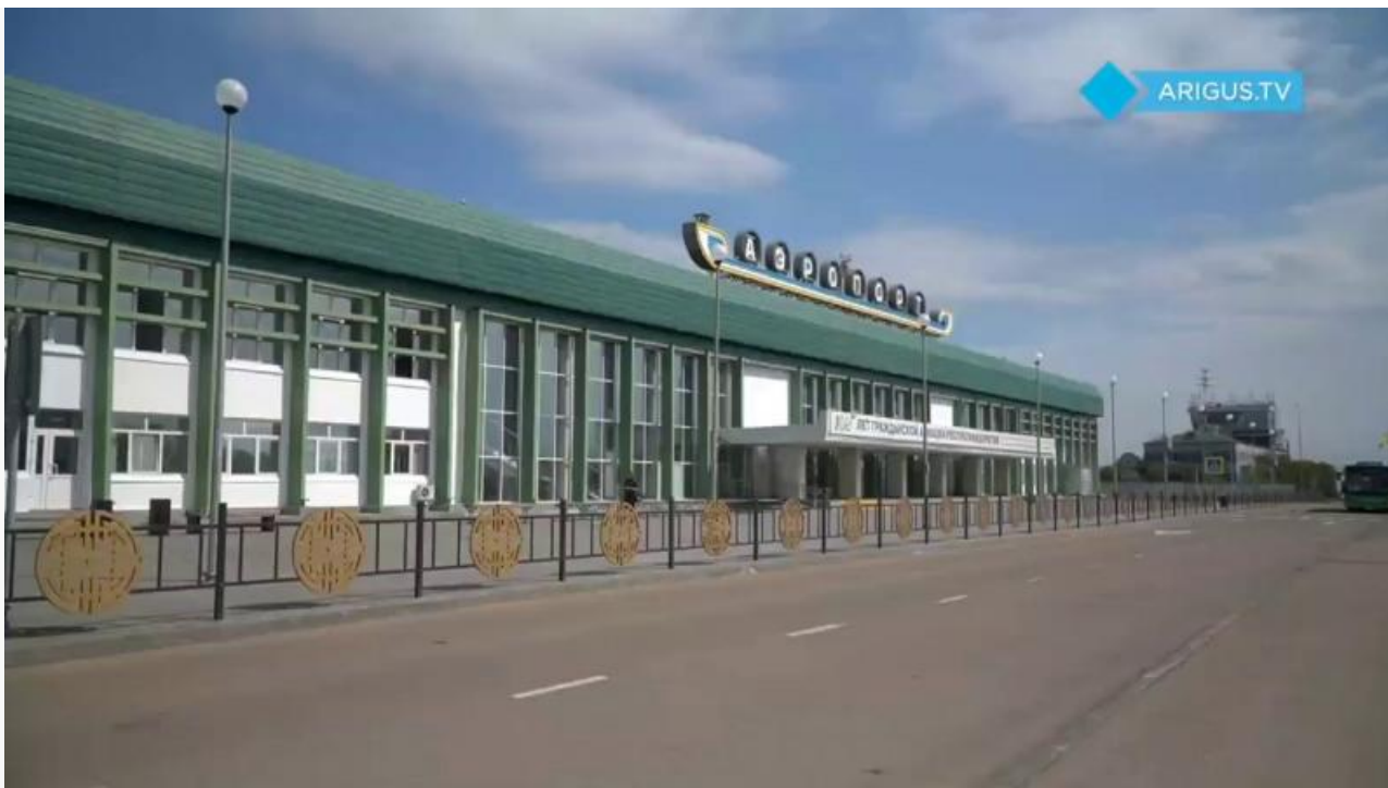
Старый терминал после ремонта
