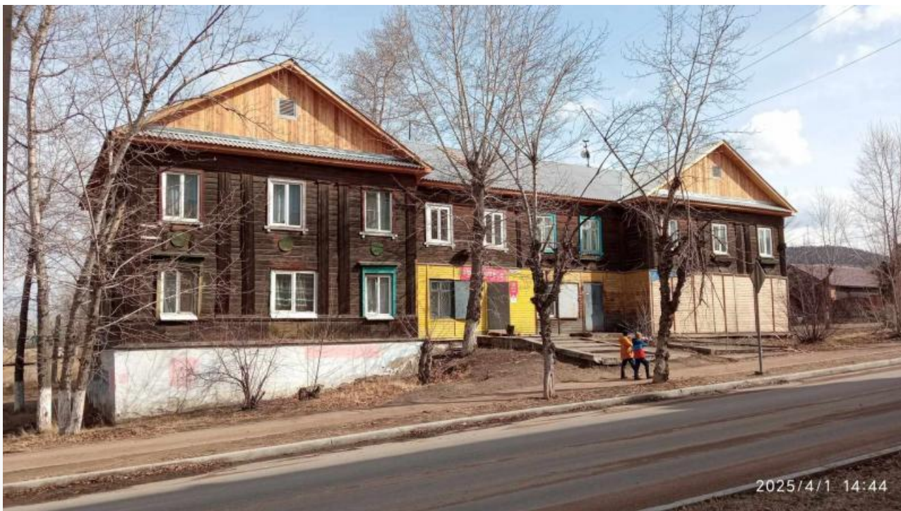
Дом по адресу: улица Павлова, 23. В мае Фонд капремонта Бурятии отчитался о замене кровли
