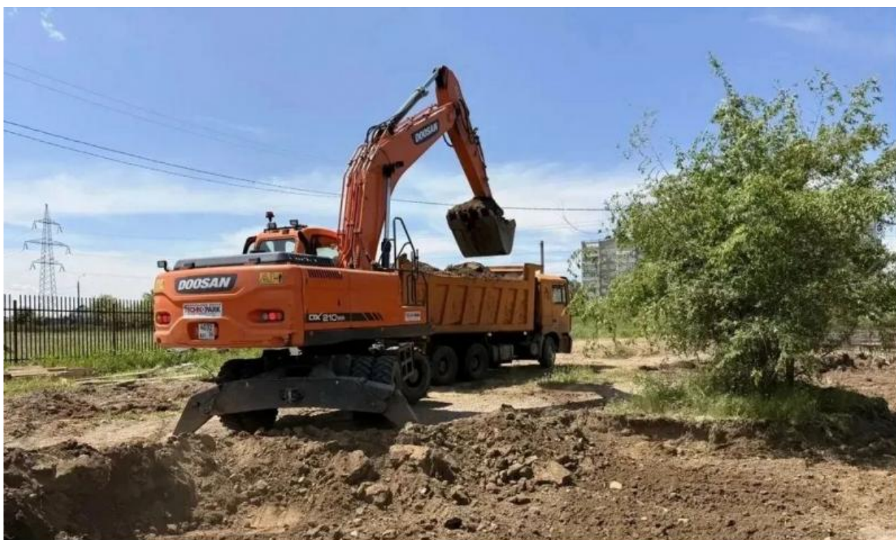
Фото: архив администрации Иркутска
