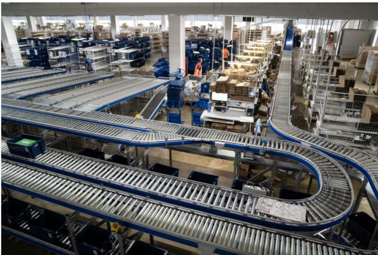
Внутреннее устройство склада Ozon с автоматическими конвейерами
