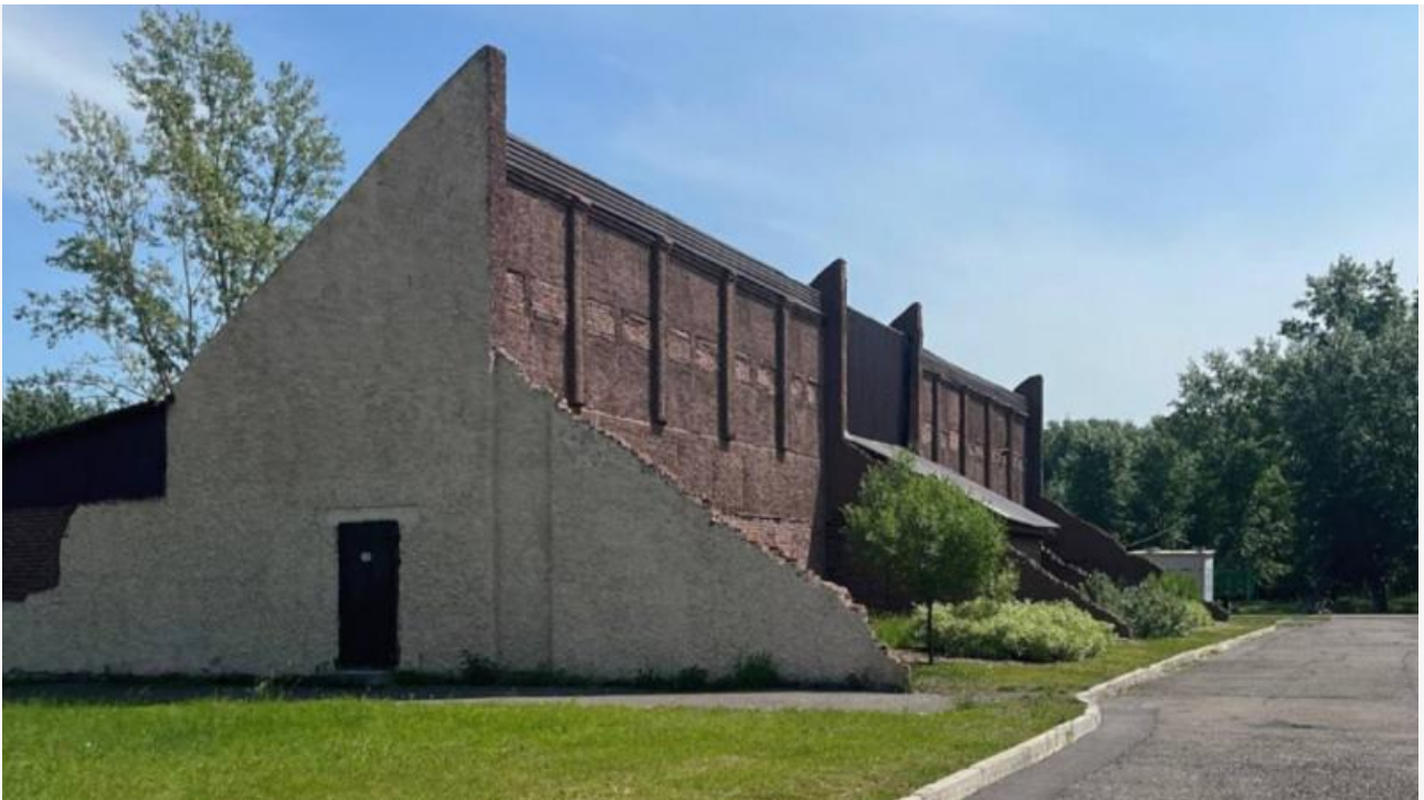
Трибуна до начала строительства
