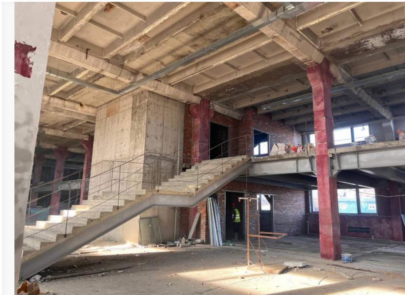
Строительная площадка Центра креативных индустрий в Улан-Удэ
