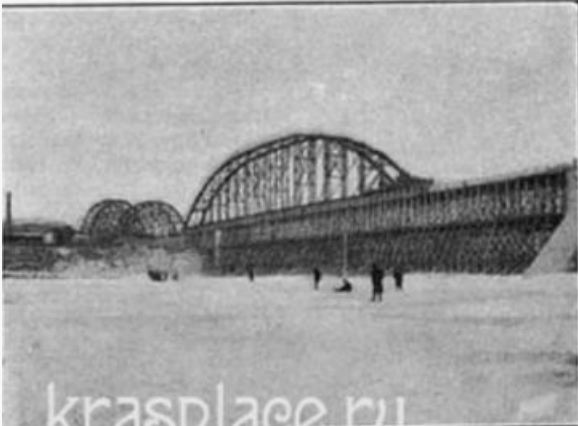
Сборка и установка арочных ферм
