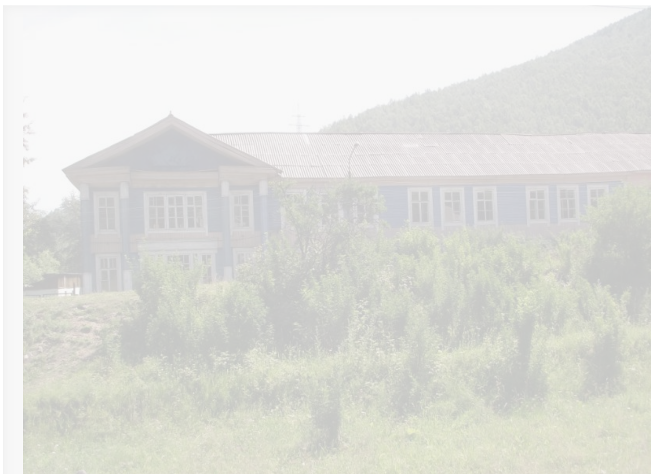
Старое здание школы №1
