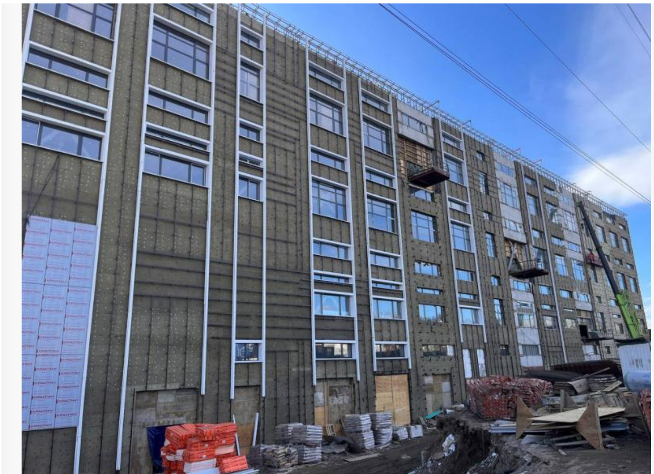
Недостроенный фасад Центра креативных индустрий. Строительные леса пустуют, облицовка отсутствует
