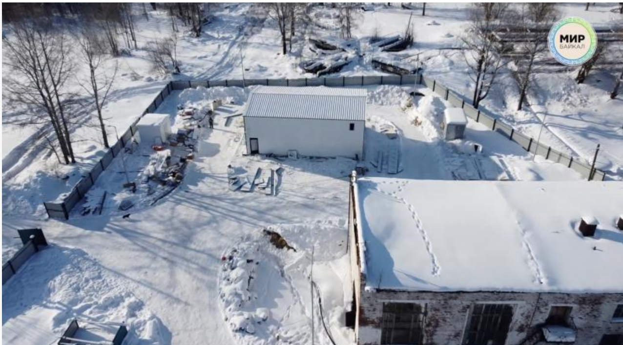
Очистные сооружения в посёлке Выдрино
