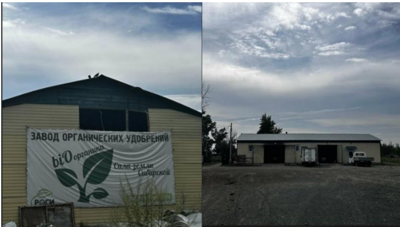
Завод по переработке отходов Черногорске (Хакасия)
