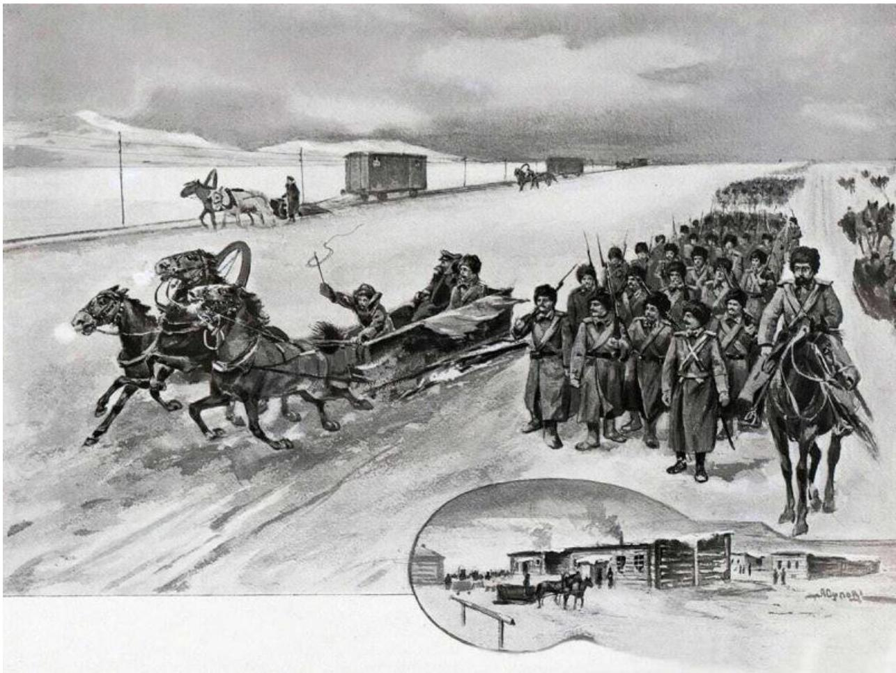
Длина ледового пути достигала около 40 километров, каждые шесть километров вдоль рельсов строились обогревательные бараки, была проложена телефонная линия и установлены звуковые сигналы для ориентирования в метель. Вагоны и локомотивы на ледовой дороге продвигались в основном конной тягой, поскольку лёд ещё не мог обеспечить безопасное движение тяжёлых локомотивов.
