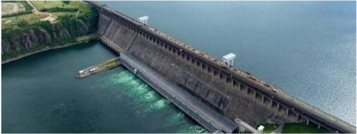
Будущее и настоящее Братской ГЭС
