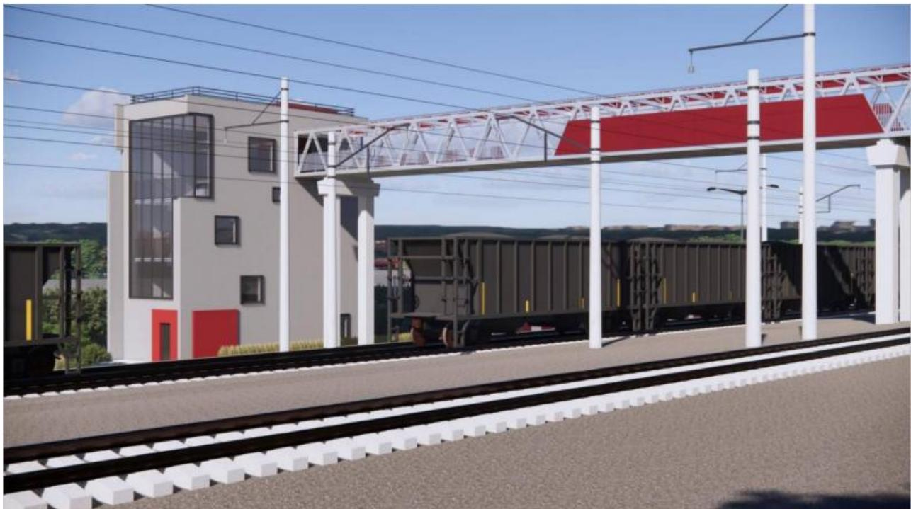
Инженеры из «Гражданпроекта» разработали конструкцию, которая объединит монолитный железобетонный каркас и сборные элементы из алюминия.
