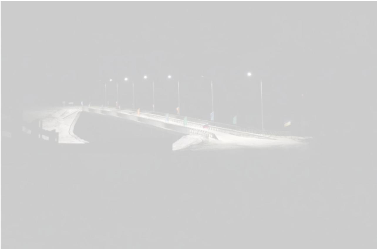
Протяженность нового сооружения – 186 метров. Там установили барьерные и пешеходные ограждения, железобетонные опоры и пролетные строения, сделали тротуары и освещение.
