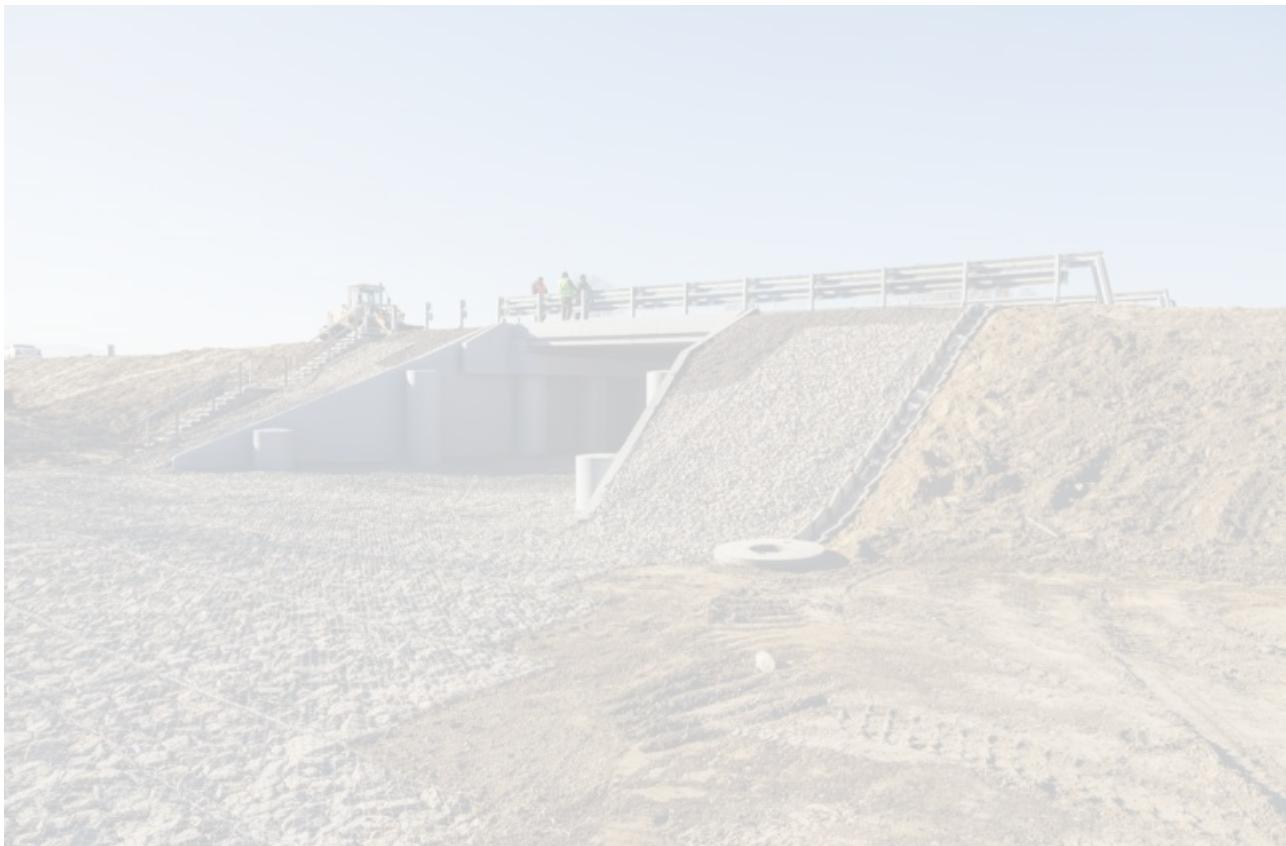
Мост, расположенный на 10 километре трассы «Тресково – Шергино – Оймур – Заречье», построили еще в 80-х. К настоящему времени он износился, конструкции заборных стенок и пролетных строений частично разрушились, появилась просадка насыпи на подходах к мосту.
