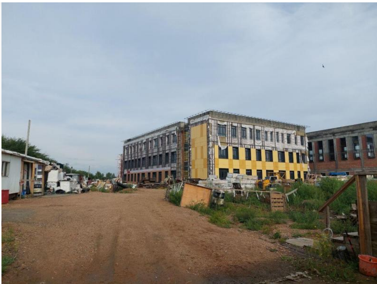
Фотография заброшенной стройплощадки от августа 2025 года
