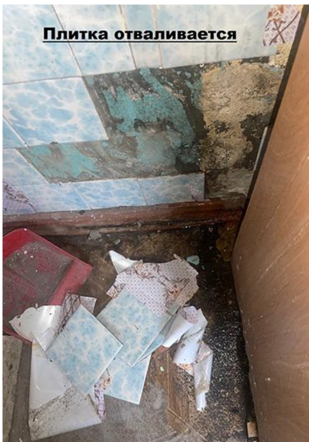
Ванная комната: стены в трещинах, известка сыпется
