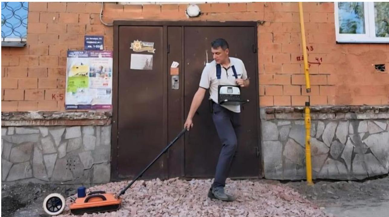
Параллельно специалисты начали геофизическое обследование участка. С помощью георадара они изучают состояние грунта по периметру здания и в подвале. Это поможет выяснить, есть ли под домом разуплотнение и другие изменения, которые могли привести к обвалу. На основе этих данных эксперты подготовят техническое решение для обеспечения безопасности здания.
