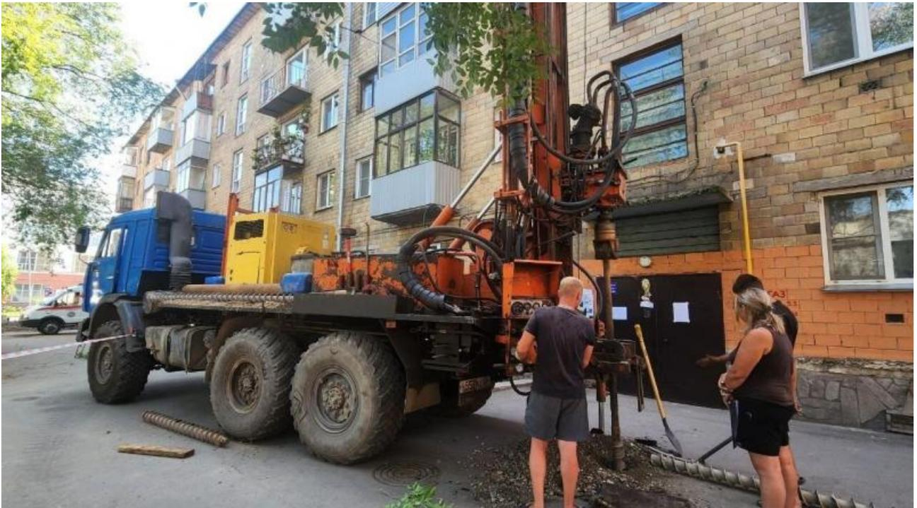
информации мэрии, первые признаки деформации грунта в этом месте зафиксировали ещё в 1970-х годах. Сейчас для точной оценки состояния фундамента и поиска подходящего технического решения специалисты планируют использовать специальное радиолокационное оборудование. Данные, полученные в ходе обследования, станут основой для проектирования работ по укреплению основания здания.
