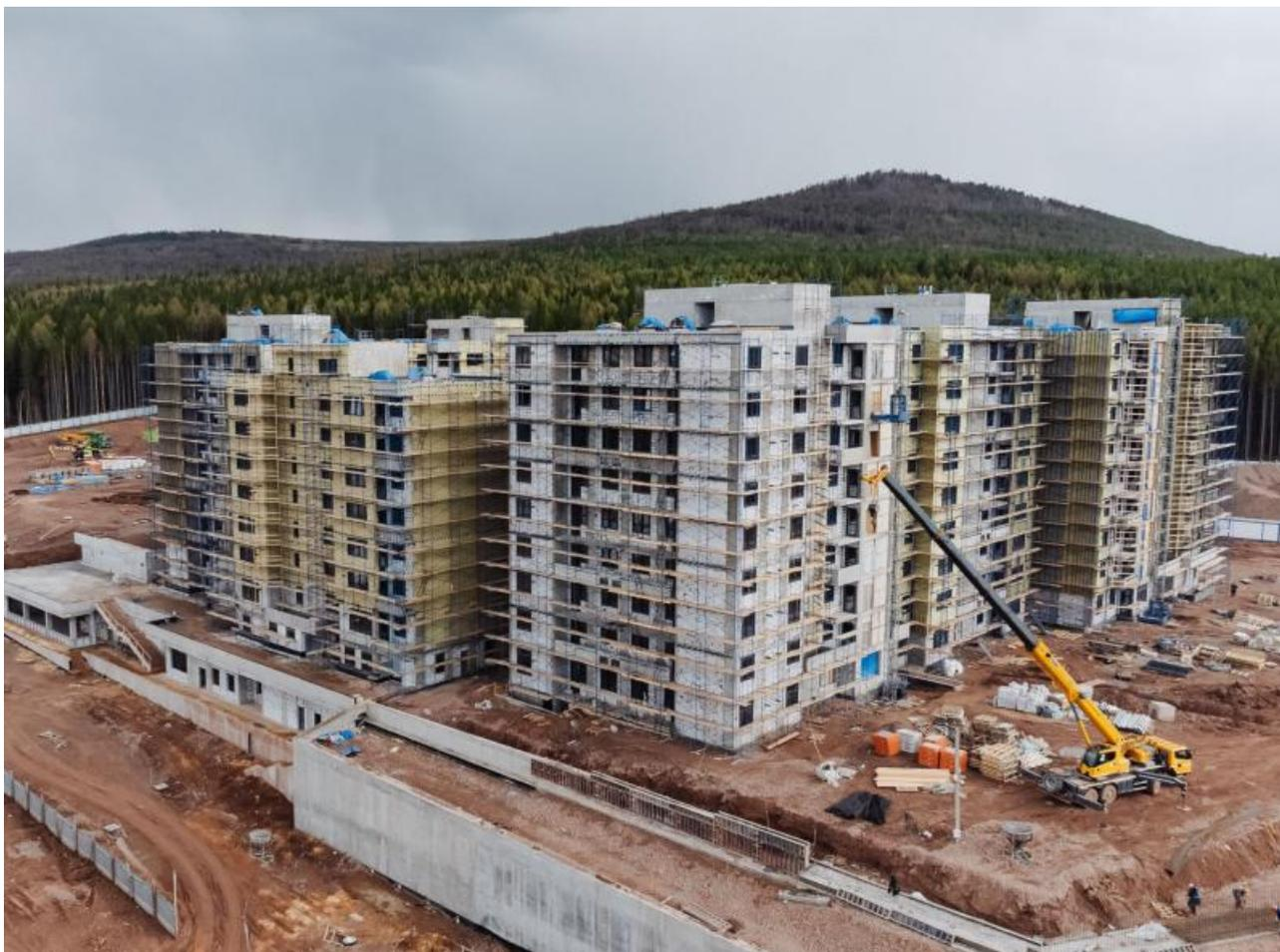
Фасадные работы тоже не стоят на месте. Уже установлены теплоизоляционные материалы, идёт монтаж витражных конструкций, а вскоре начнётся установка вентилируемых фасадов и облицовочных панелей. Благоустройство территории не отстает: ведётся планировка участка, отсыпка щебнем и укладка бордюрного камня для будущих тротуаров и пешеходных дорожек. В июле строители приступят к монтажу наружных электрических сетей.
