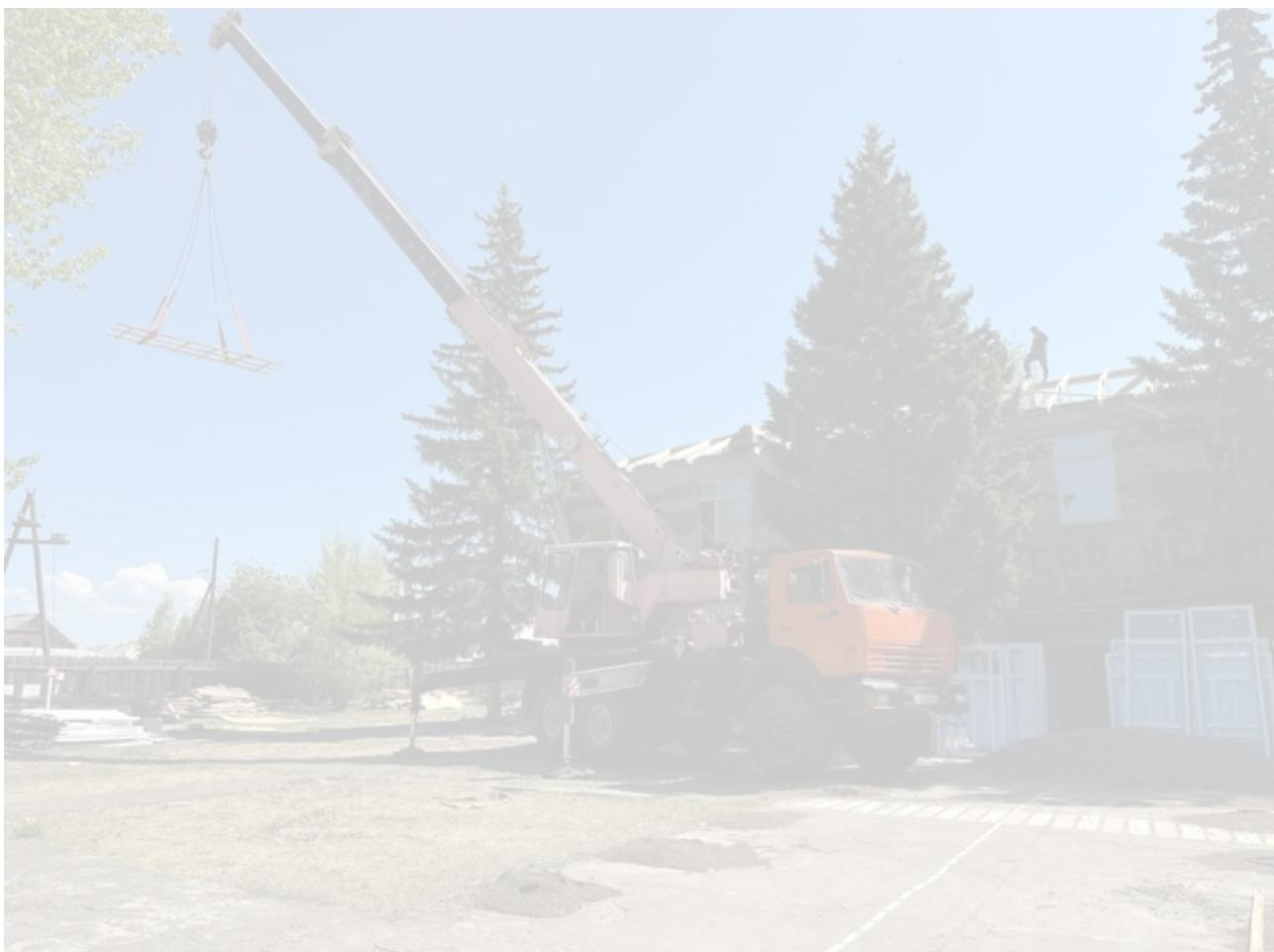
Сперва там выровняли стены и потолки, а также демонтировали старую крышу, полы и электропроводку. Сейчас подрядчик занят шпаклевкой и штукатуркой стен и потолков, утеплением фасада, заменой кровельного покрытия и установкой новой проводки. Вскоре рабочие возьмутся за демонтаж старых окон и установку новых.
