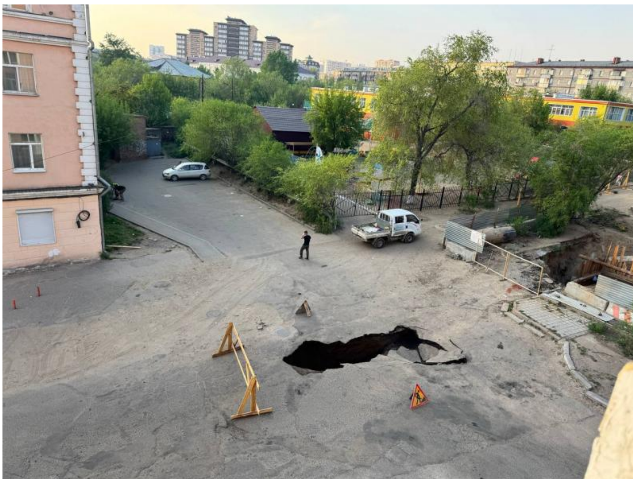
Фото: «Водоканал» Улан-Удэ
