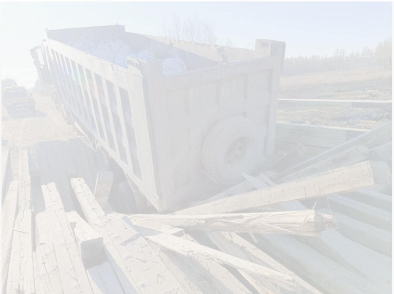
«Грузовой автомобиль нарушил установленные ограничения по весовым нагрузкам – шесть тонн на ось, и повредил мост через ручей Хурета на 398 км трассы Улан-Удэ-Романовка-Чита (в 22-х км от села Романовка)», - рассказали в ведомстве.
