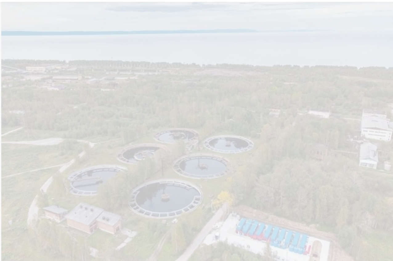
Карты-накопители, понижающие уровень надшламовых вод - единственное современное сооружение на территории Байкальска по очистке вод, стекающих в Байкал
