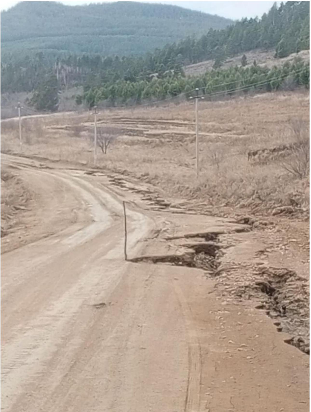
Работники Тарбагатайского дорожно-эксплуатационного управления засыпали провал для восстановления движения транспорта. Также специалисты очистили главную трубу, через которую сбрасывается вода.
