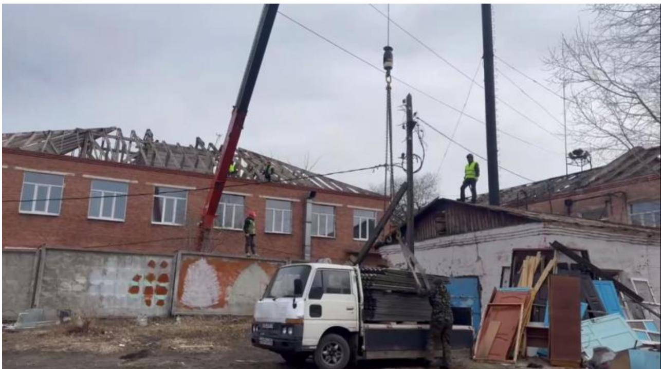
Там заменят кровлю, инженерные коммуникации, двери, окна и санузлы, а также сделают новый фасад, укрепят фундамент, сделают утепление, выровняют стены, полы и потолки. Также без внимания не останутся пищеблок и актовый зал.
