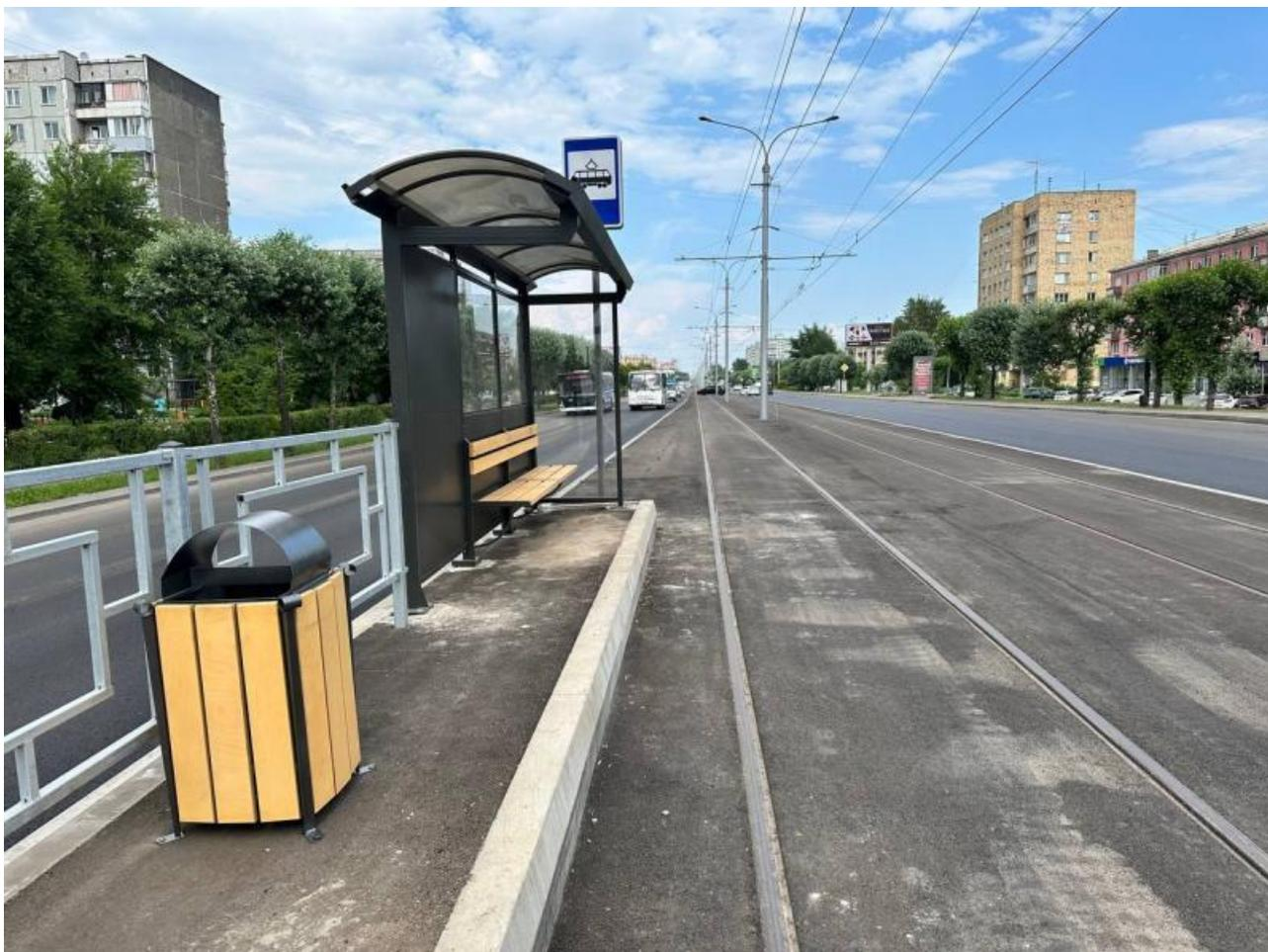
Реконструкция, которая продолжалась девять месяцев и стоила краевому бюджету 816 миллионов рублей, оказалась недолговечной. Основная проблема заключается в технологии укладки: рельсы просто положили на асфальт без дополнительного укрепления. На другом участке, отремонтированном ранее с использованием специальных плит, подобных проблем не возникло. Из-за возникших дефектов вагоновожатым приходится снижать скорость, чтобы избежать аварийных ситуаций.
