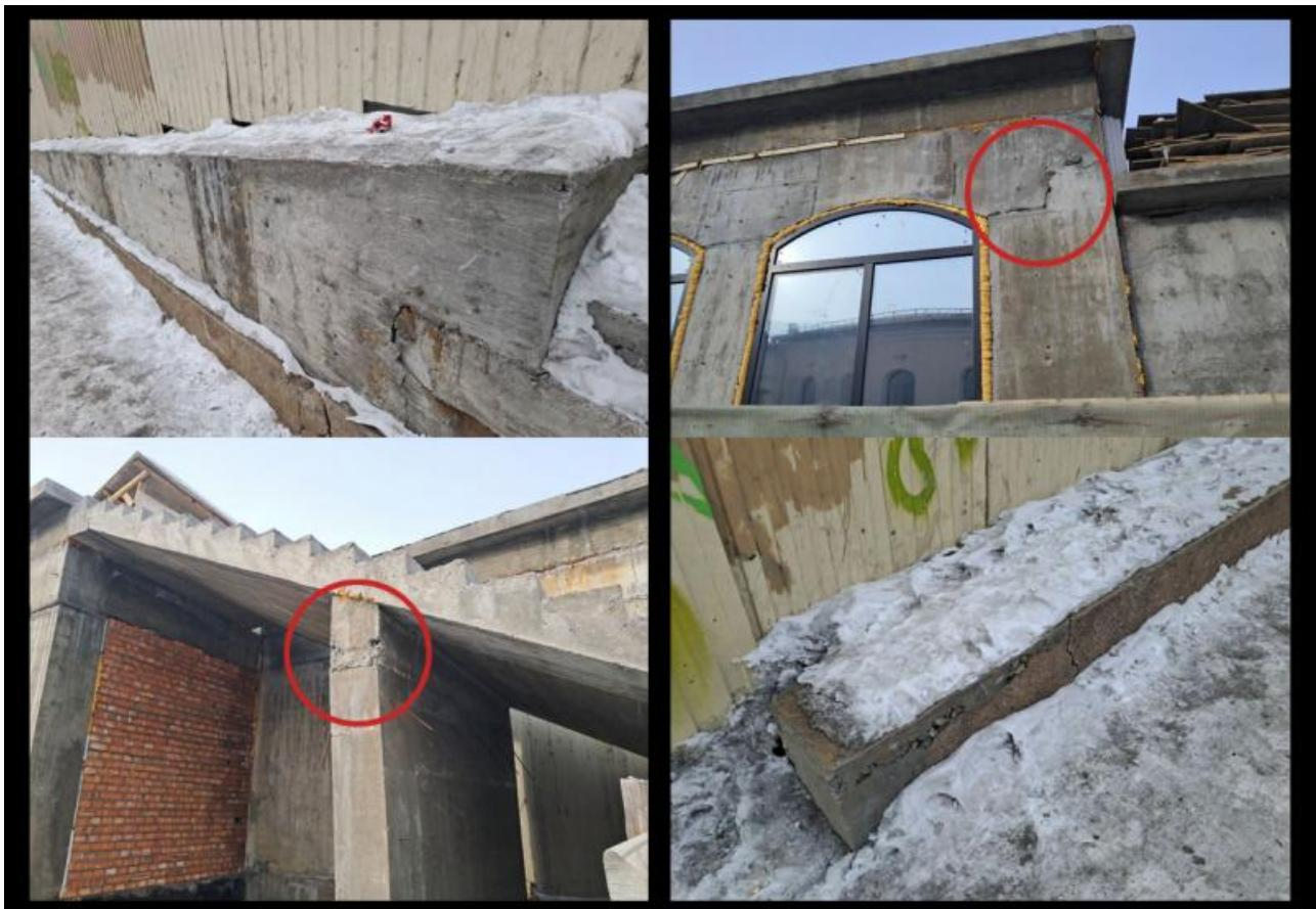
Некоторые бетонные блоки не выглядят монолитно в основании, что создает риски при эксплуатации здания, а также безопасности граждан.
