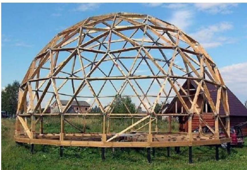
Также отличия технологий в том, что в геодезическом куполе окна могут быть только треугольной формы, а в стратодезическом – прямоугольной.
