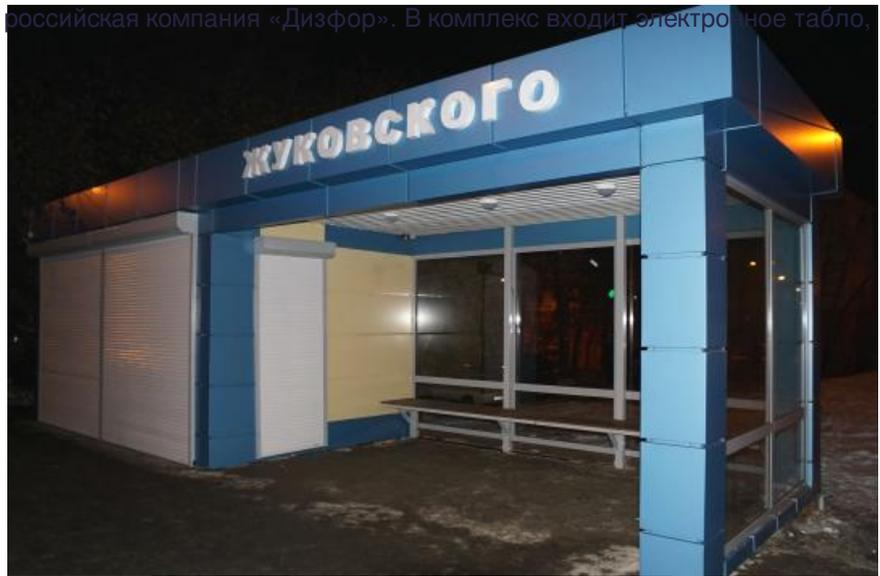
При изготовлении павильона применяется металлический профиль, алюминиевые композитные панели, монолитный поликарбонат, травмобезопасное стекло и перфорированный металл. Информационная система позволяет ознакомиться с интерактивной картой города и дает возможность проложить на карте индивидуальный маршрут, а после быстро скопировать его на мобильное устройство.
