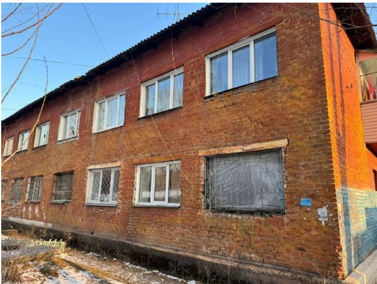
Двухэтажный кирпичный дом признали аварийным еще в 2016 году. В апреле 2022 года его состояние значительно ухудшилось. Независимая экспертиза показала 76% износа конструкции здания.
