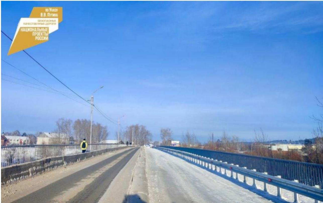
Дорожники починили балки, межбалочные швы, заменили конструктивные элементы на съездах, установили барьерное и перильное ограждение, обновили асфальтобетонное покрытие.
