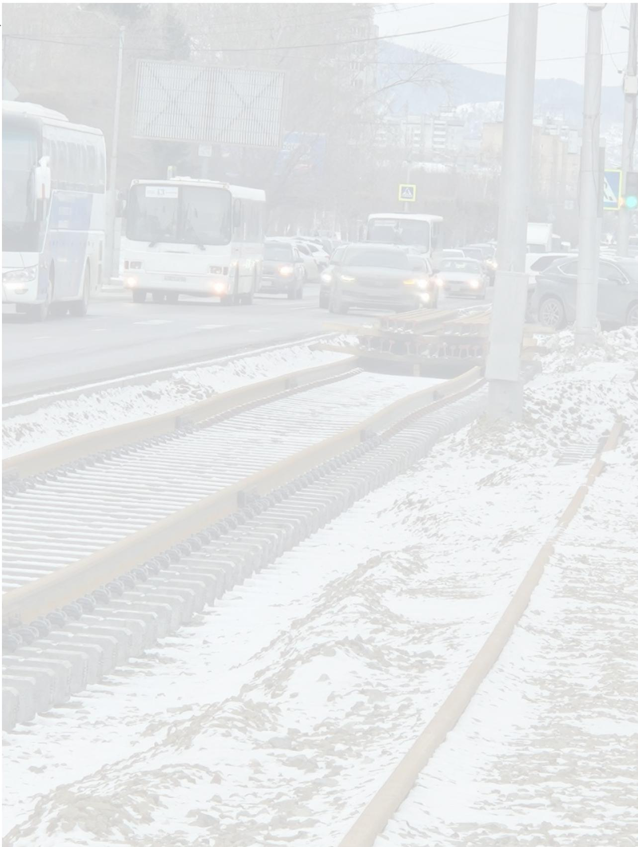
уже в июле нарушения выявила прокуратура. Проверка показала, что после завершения реконструкции путей перепад высот между насыпью трамвайного полотна и проезжей частью составлял 30 сантиметров, что не могло обеспечить плавное и безопасное движение транспорта. Тогда представителю «Промстроя» объявили предостережение. Устранить недостатки подрядчик должен был за свой счёт.
