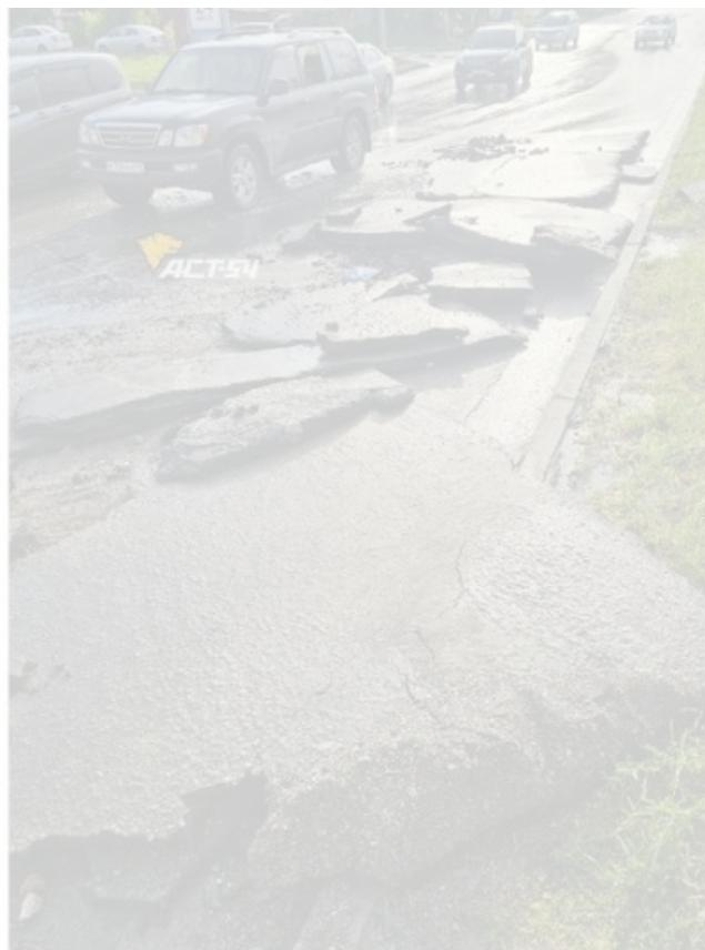
Наверняка всем интересно то, как же мэрия прокомментировала данную ситуацию. Сообщается, что ранее на пересечении улиц Мясниковой и Кочубея был уложен асфальт на бетонные плиты. Со временем покрытие испортилось, а после возникшего потока воды пласты асфальта смыло. По всей видимости, всё просто вот так и работает: дождик пошёл, асфальт поплыл. Непонятно только, почему все решили умолчать о том, что ливневая канализация на участке просто была проигнорирована.
