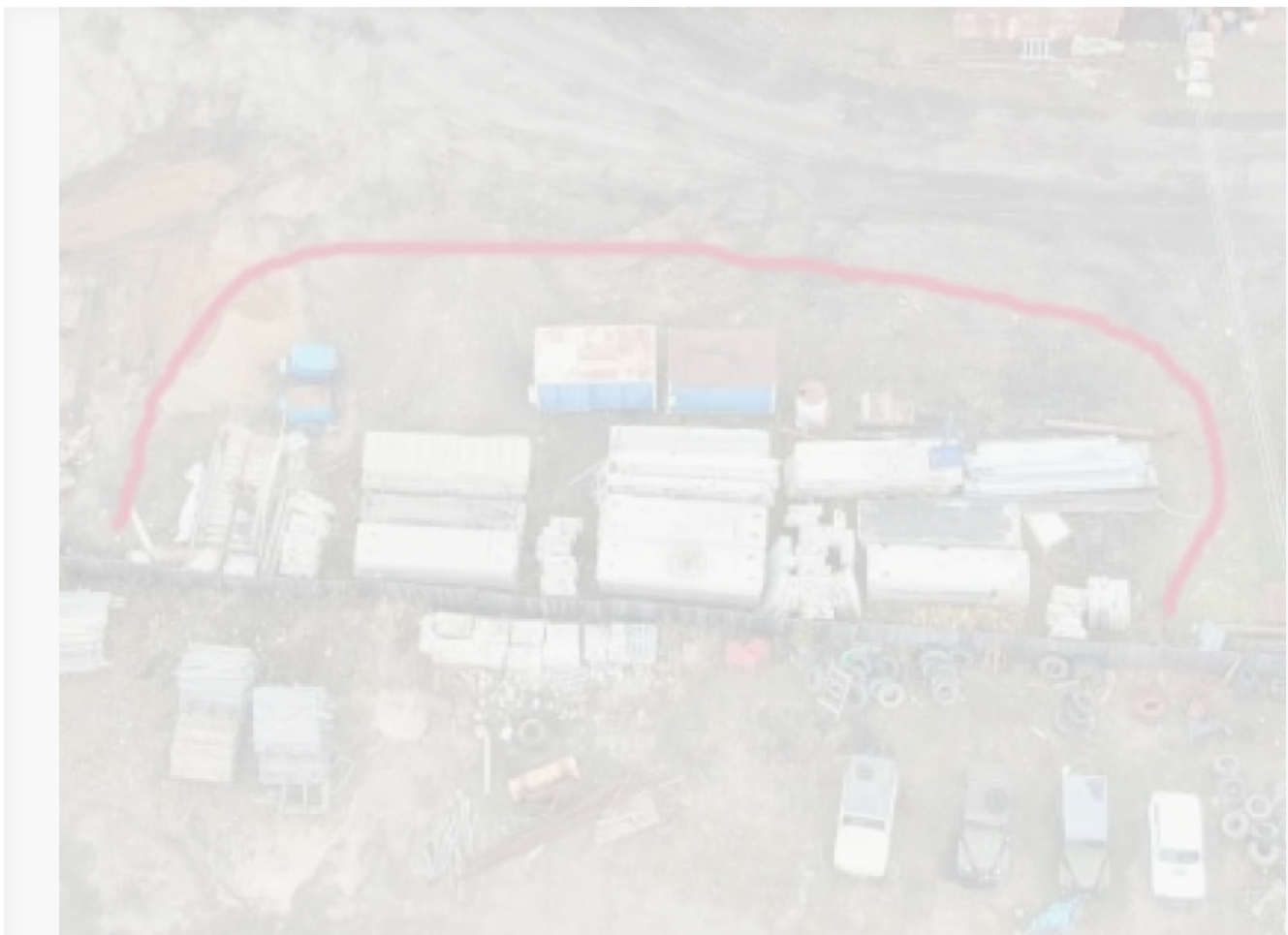
Снимок территории ООО «Теплоснабжение», красным обведено место складирования элементов каркаса, май 2024-го
