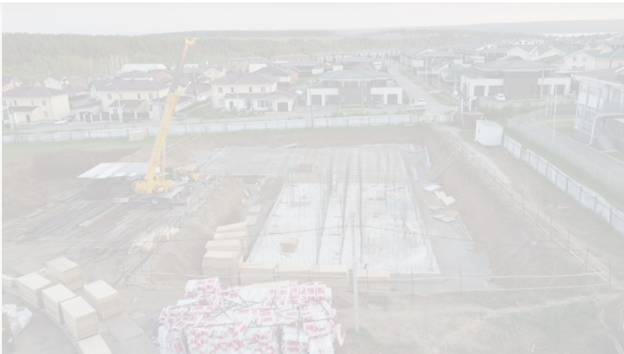
Котлован под строительство пятиэтажного дома
